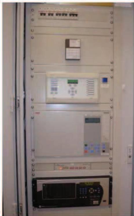
Figura 7. Armario de control y protección de línea AT
