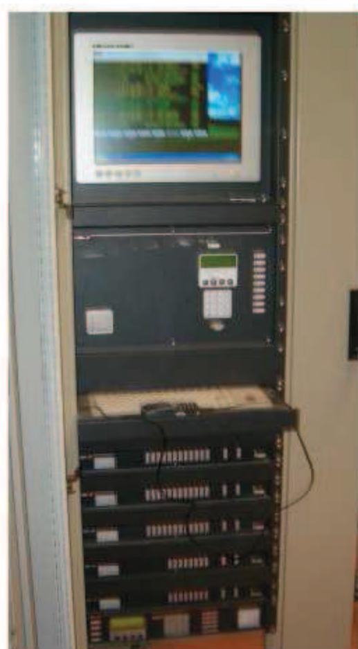
Figura 8. Unidad Central de Subestación (CCS)
