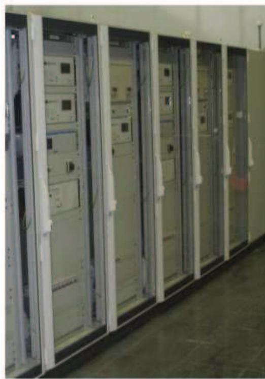
Figura 6. Conjunto armarios control y protección
